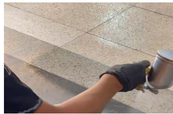
RENOVAÇÃO DE TOPCOAT
