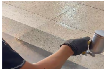
RENOVACIÓN DEL ACABADO
