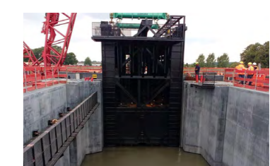
PUERTAS DE ESCALERA
